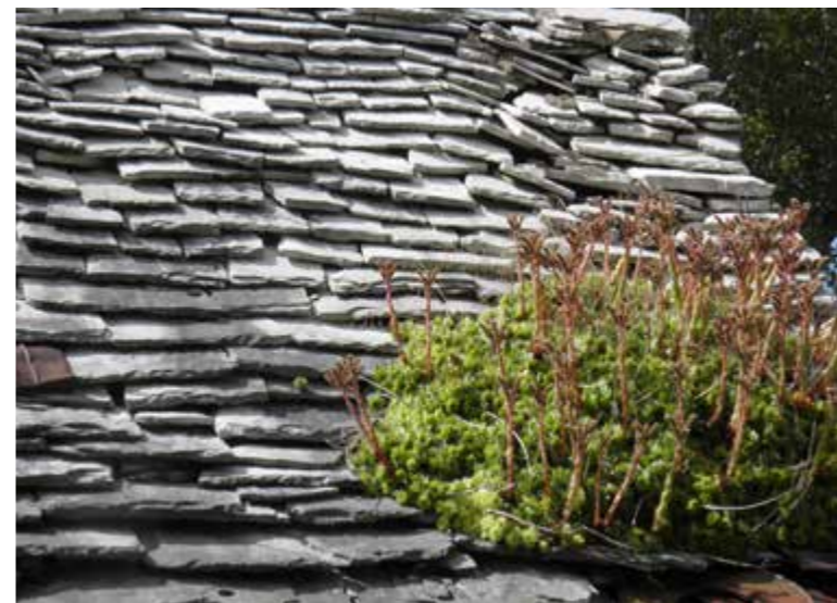
Koliki je bio problem drvene građe, vidljivo je na ovom raskrivenom krovu (gore). Krovini pokrov (neomazane kamene ploče) sa čuvar-kućom - kultnom biljkom dalmatinskog zaleđa (dolje).
