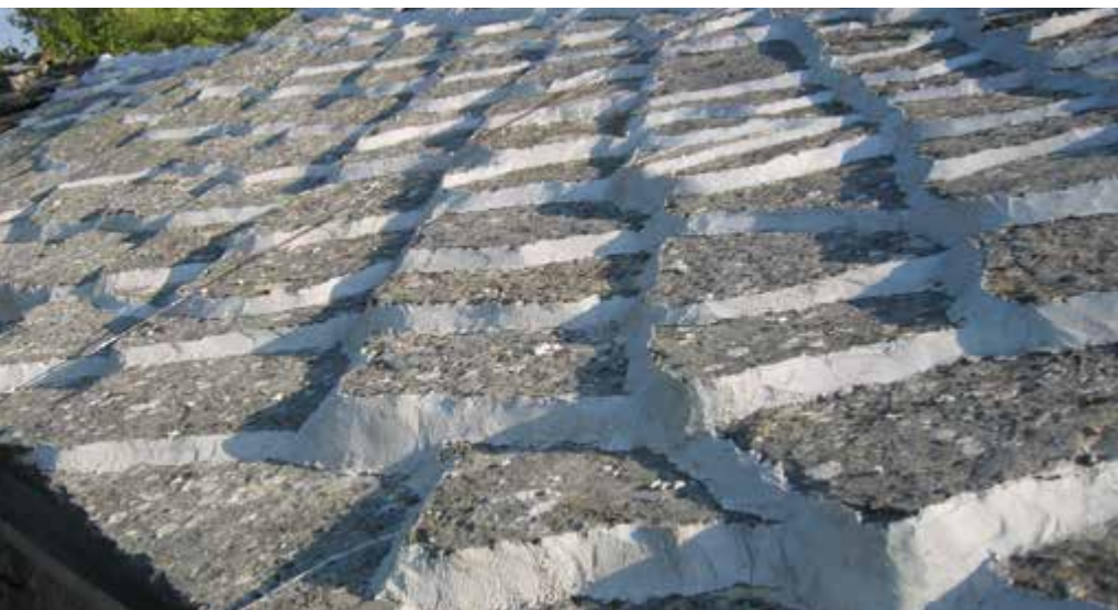
Slog pokrivanja kamenim pločama u Bukovici i u Ravnim kotarima. Ovdje letvanje nije potrebno zato što veliki formati ploča (kakvi se nalaze u prirodi) prekrivaju i tri roženice. Spojevi su omazivani vapnenim mortom da se spriječi prokišnjavaње i propuhivanje (dolje)
