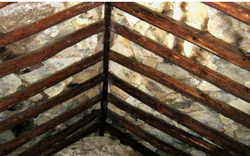
Slog pokrivanja kamenim pločama u Bukovici i u Ravnim kotarima. Ovdje letvanje nije potrebno zato što veliki formati ploča (kakvi se nalaze u prirodi) prekrivaju i tri roženice. Spojevi su omazivani vapnenim mortom da se spriječi prokišnjavaње i propuhivanje (dolje)
