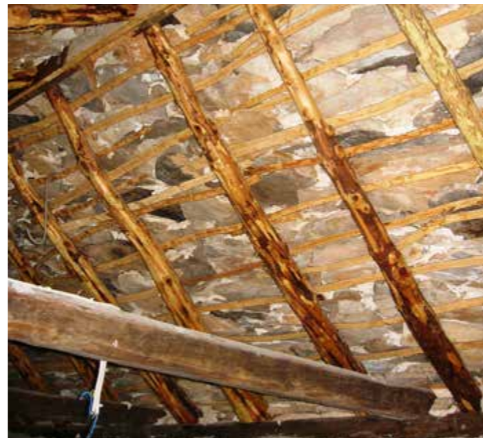
Slog pokrivanja (u redove) kakav zatječemo u čitavom kraju (i u većini Sredozemlja). Roženice letvane (najčešće) raspolovljenim granama (jasena), što osigurava trenje i sprječava klizanje kamenog pokrivača.
