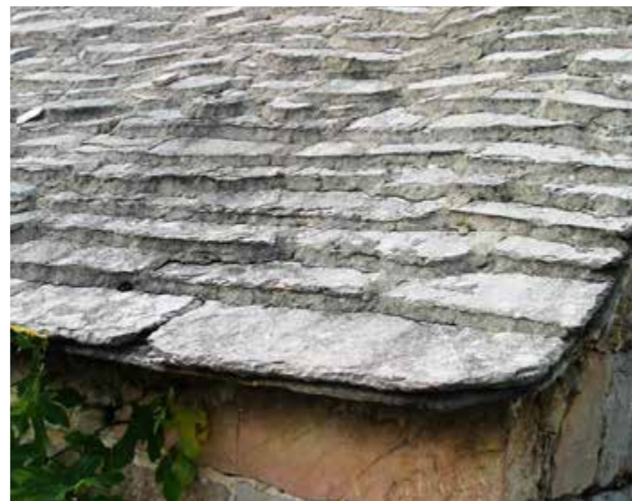
Slog pokrivanja (u redove) kakav zatječemo u čitavom kraju (i u većini Sredozemlja). Roženice letvane (najčešće) raspolovljenim granama (jasena), što osigurava trenje i sprječava klizanje kamenog pokrivača.
