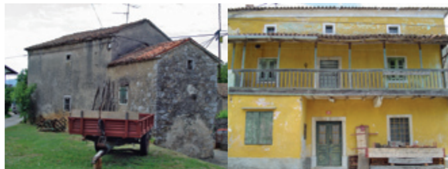
Pogled na fasado proti burji (desno) in osončeno glavno fasado (desno) istega objekta. Avtor fotografije: Aleksandra Torbica
