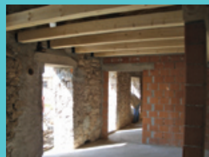
Izvedba nadomestne lesene stropne konstrukcije. Avtor fotografije: Nataša Kolenc
