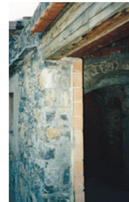
Notranje obzidavanje z vmesno izolacijo - primerno le v določenih primerih. Avtor: Igor Premzl
