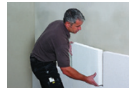
Izvedba notranje izolacije s ploščami kalcijevega silikata.
