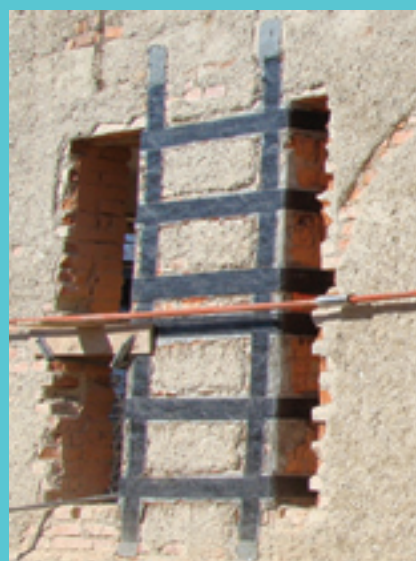
Ojačitev slopa med odprtinama s karbonskimi trakovi. Avtor fotografije: Mojca Jarc Simonič
