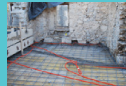
Izvedba nadomestne polne AB plošče. Vir: Arhiv Graditeljstvo Henigman d.o.o.
