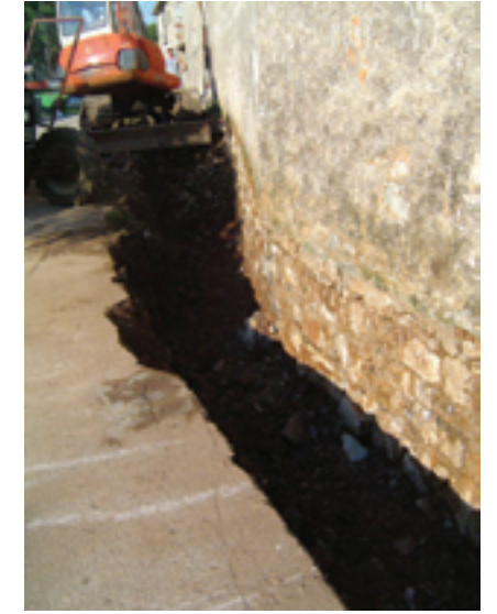
Prikaz izkopa za izvedbo drenaže objekta, ki je na cestni strani vkopan za celo etažo. Avtor fotografije: Nataša Kolenc
