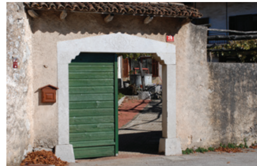
Primer kolone z klasičnim kraškim koničastim gurencem (preklado) Vir: Pepa s Krasa • Avtor fotografije: Borut Benedejčič
