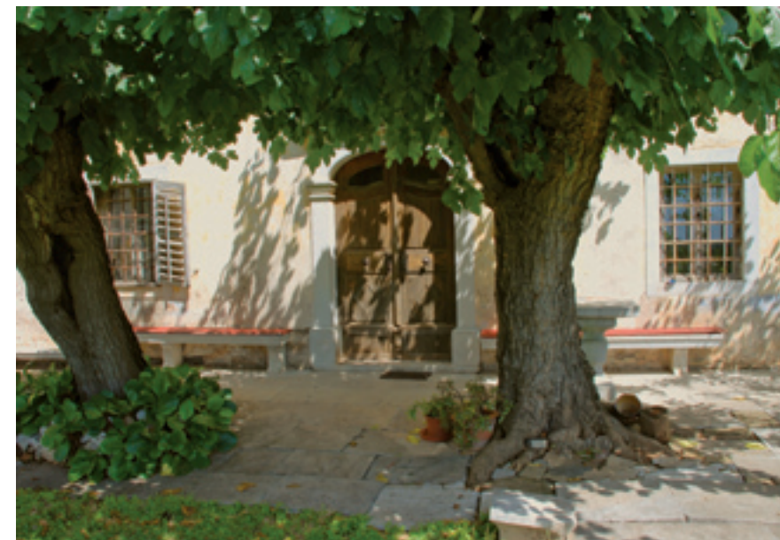
Primer tlakovanja s škrlami pred vhodom v hišo • Avtor fotografije: Stanko Vitez
