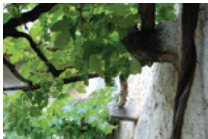
Kamnit nosilci na hišnem pročelju • Vir: Pepa s Krasa Avtor fotografije: Borut Benedejčič
