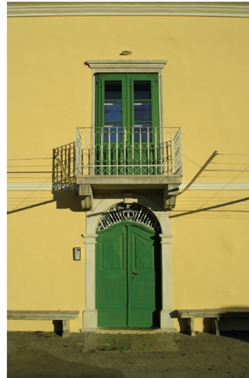
Matavun - v pritličju restavrirana vhodna vrata, medtem, ko so nova balkonska vrata izdelana kot kopija starih vrat. Restavrirani so tudi kamniti in kovani elementi. Avtor fotografij: Arhiv OCRA Obrtni center restavradorstva d.o.o.
