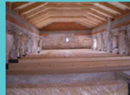
Utrditev zatrepane stene z izvedbo horizontalne vezi in pozidavo »trikotnika« na novo. Avtor fotografije: Dario Grilanc
