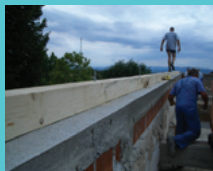
Sidranje kapne lege na AB vez s kovinskimi sidri. Foto: Dario Grilanc
