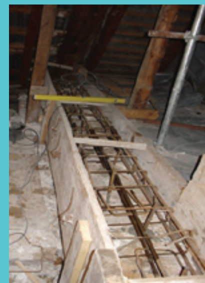
Izvedba AB okvirja - Vir: Arhiv GI ZRMK
