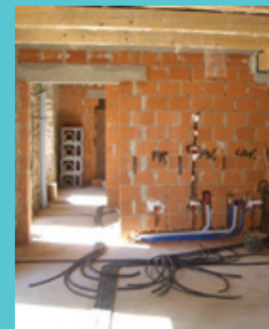
Izvedba novega prečnega nosilnega zidu v kamniti hiši, zidanega iz modularne opeke. Avtor fotografije: Dario Grilanc
