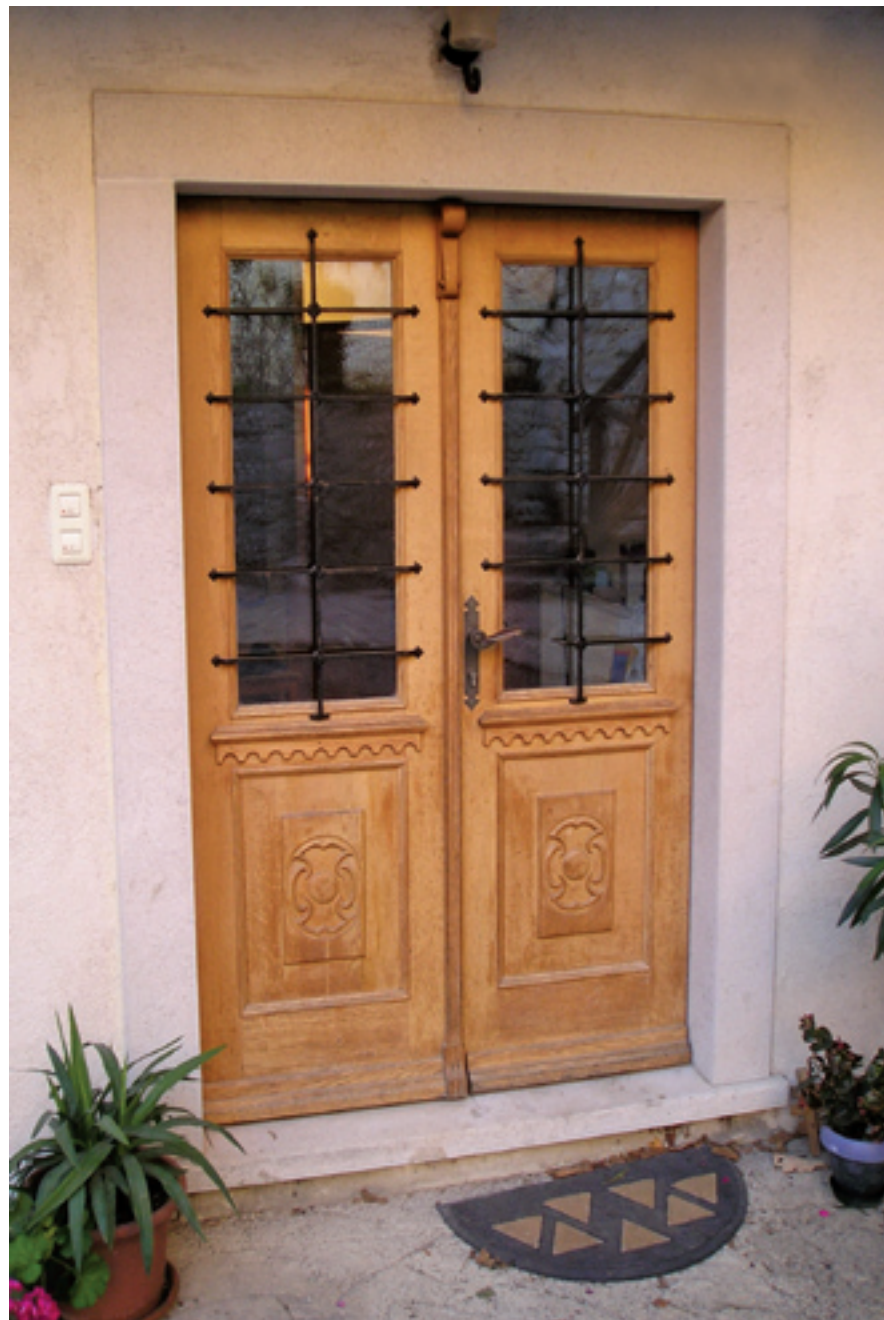
Štanjel - v celoti na novo izdelana vhodna vrata, ki so dober primer kako nadomestiti manjkajoča ali preveč poškodovana stara vrata. Vir: Arhiv OCRA Obrtni center restavradorstva d.o.o.
