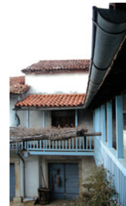
Tradicionalni žlebovi so polkrožne oblike, z vidnimi kljukami in izdelani iz sive pocinkane pločevine. • Avtor fotografije: Nataša Kolenc
