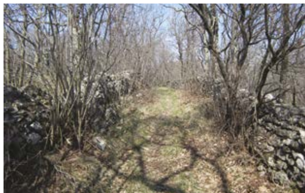
Slika 31: Med Seli na Krasu in Koritom drevesa podirajo zid iz apnenčeve breče.
