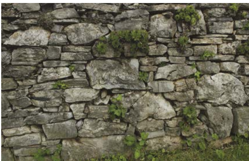
Slika 19: Navadni netresk v podpornem zidu v Gabrovici pri Komnu (Lok. 6)
