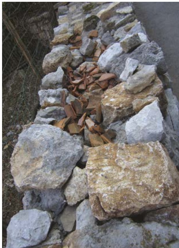
Slika 88: Suhi kraški zid marsikje vsebuje kose opeke in drugega materiala, ki v suhi kraški zid ne sodi.
