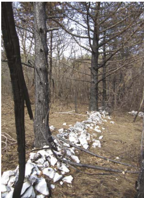
Slika 30: Drevesa podirajo zid iz alveolinsko-numulitnega apnenca.
