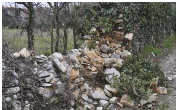
Slika 36: Suhi kraški zid se je porušil zaradi bioerozije in nevzdrževanja.
