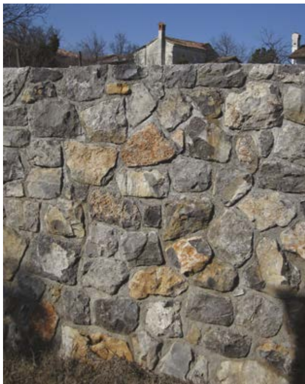
Slika 86: Sicer dokaj skrbno izdelan zid, vendar je kamen oklesan in obdelan, kar pa ni običaj v tradicionalnih suhih kraških zidovih.
