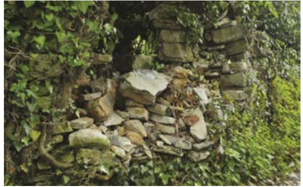
6 Kamnit podporni zid (škarpa) v vasi pri hiši Gabrovica pri Komnu 23a
