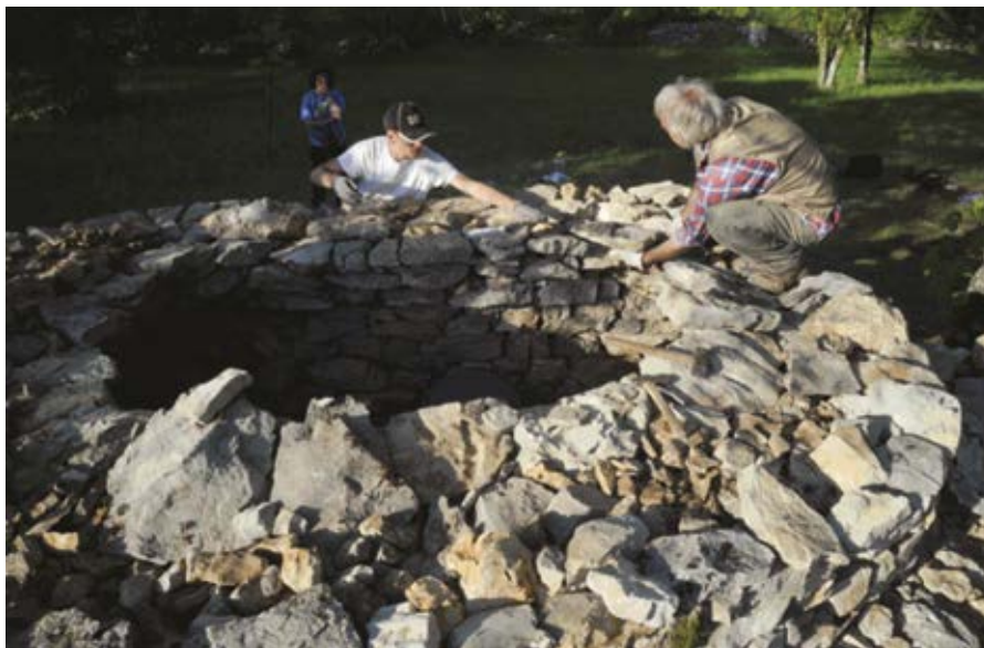
Slika 26: V prerezu ločujemo notranje plasti od zunanega okvirja. Vloga zunanega okvirja je dvojna:
