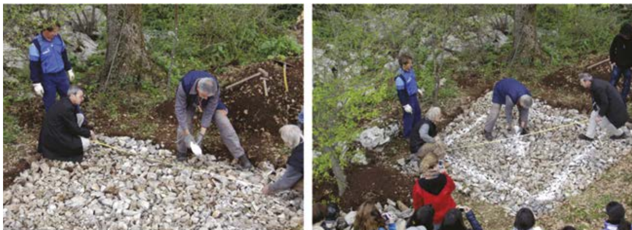
Slika 10: Pozicioniranje objekta z načrta na temeljno posteljico
