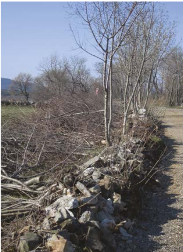
Slika 35: Kraški zid pred Štorjami je popolnoma obrasel z grmovjem in drevesi, kar ga je precej poškodovalo.
