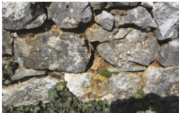
Slika 90: Prst in/ali ilovica med kamnitimi kosi suhega kraškega zidu v Komnu
