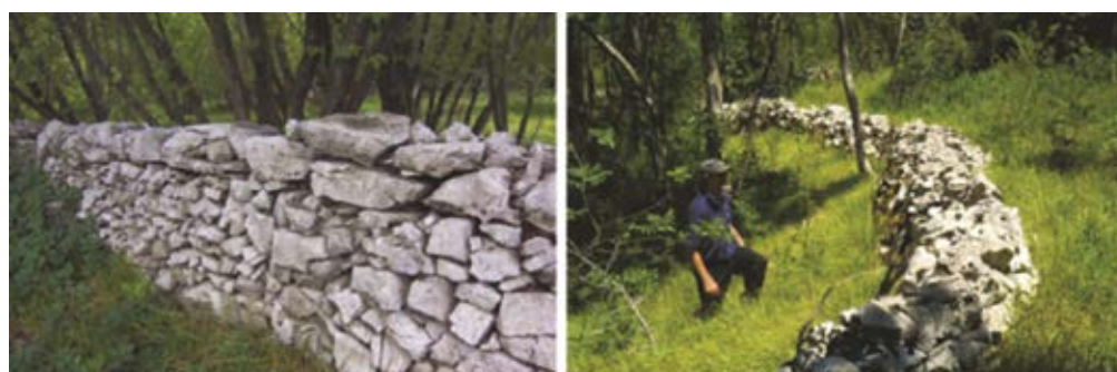
Slika 22: V zid lahko vgradimo tudi kamnite konzole. Konzole so v zid umeščene tako, da nanje polagamo lesene kole, ki nam služijo pri gojenju trte - nanje vežemo njene veje. Zid s konzolami v tem primeru dobi vlogo varovala pred vetrom in nosilca kolov ter tudi pridobi vlogo v vinogradništvu. Kamenje v zidu se čez dan ogreje in po sončnem zahodu oddaja toploto ter tako sodeluje pri zorenju grozdja. Konzole so le grobo oblikovane z grobimi detajli.
