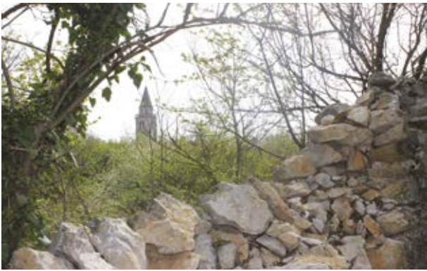
Foto 5, 6: I muretti in pietra a secco in grave stato di degrado, causa assenza di manutenzione. Fotografa: Romana Kačič, 2014.
