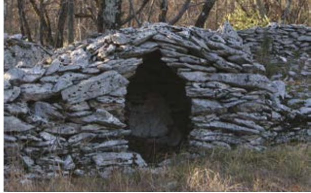
Foto 2: Gropada: Hiška con volta in aggetto a carena / v zidu in previsevanje - velb. Fotografia: Boris Čok, 2009.
