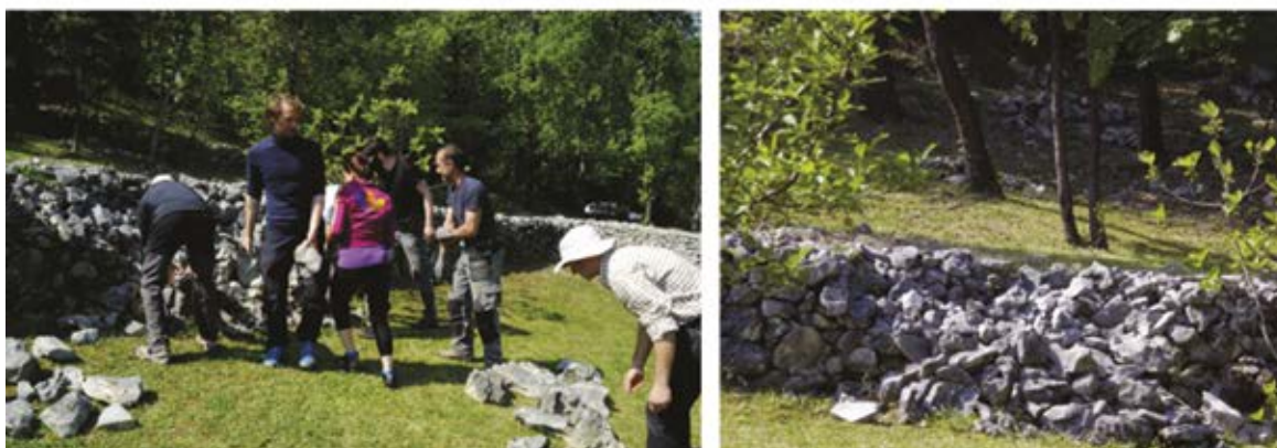
Slika 16: Pri zlaganju kamna na suho moramo biti pozorni tudi na prostorsko obliko gradnikov. Pri primeru (a) je bil kamen na svoji poziciji verjetno dobro vstavljen in stabilen, vendar je imel zgornjo ploskev nagnjeno navzven. Taka izvedba močno oslabi jedro zidu. Posledica slabitve so lokalne porušitve, te se zgodijo postopoma, saj gradniki postopoma drsijo navzven. Stabilna struktura konstrukcije je taka, da poleg obveznega prekrivanja fug v vseh razsežnostih upoštevate tudi obliko kamna. Na shemi (b) je prikazana rešitev, pri kateri so kamni zloženi tako, da so ploskve nagnjene navznoter proti osi zidu.
