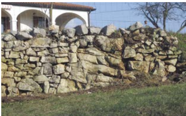
Slika 83: V Krajni vasi so kraški zid naredili na izdanku apnenca, ki vpada poševno, kar seveda predstavlja dodatno oviro pri gradnji zidu.
