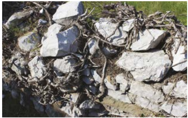
Foto 5, 6: I muretti in pietra a secco in grave stato di degrado, causa assenza di manutenzione. Fotografa: Romana Kačič, 2014.
