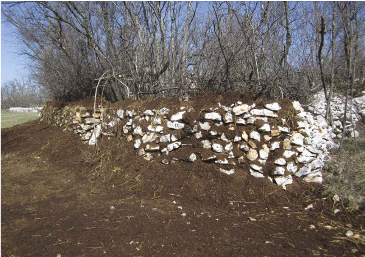
Slika 91: Takšne prakse so se lotili tudi pri gradnji suhega zidu desno od ceste proti Lokvici (leto 2013).
