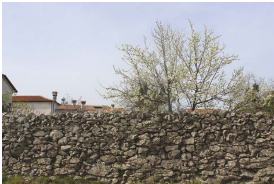
Foto 7: Un muretto in pietra alto circa due metri delimita la proprietà privata. Le norme tecniche del nuovo PRG del Comune di Trieste, invece, consentono all'interno dell'area comunale la realizzazione di nuovi muri a secco con un'altezza massima di un metro il che porterà allo sviluppo di recinzioni miste, non tipiche per il Carso. Fotografa: Romana Kačič, 2014.
