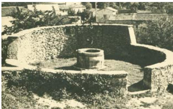
Foto 10: Muro attorno il pozzo della Comunella di Grozzana / Gročana. Fotografo: Presl Mitja, 1958.
