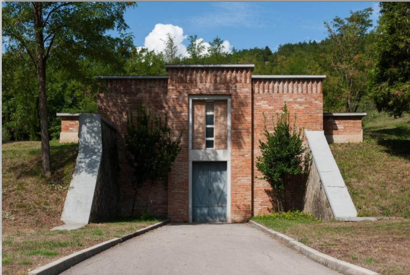
Cepki - Zbiralnik in čistilna naprava Rižanskega vodovoda
